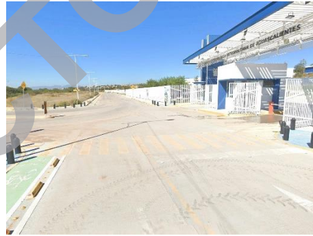
Av. Gerónimo de la Cueva en el lado del arroyo y emplazamiento de la Universidad Tecnológica Metropolitana de Aguascalientes
